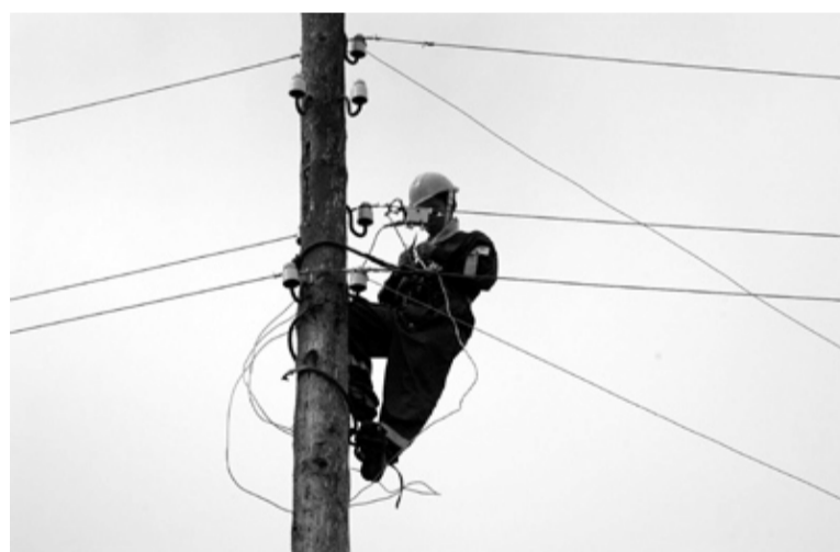
Монтаж системы АСКУЭ
