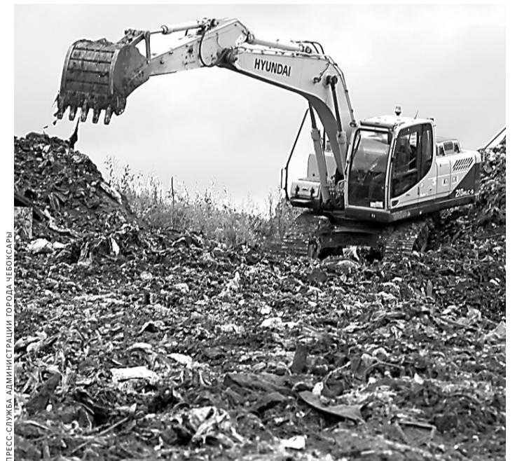
Сначала полигон полностью покроют обычным грунтом и глиной, а затем закроют геомембраной.
