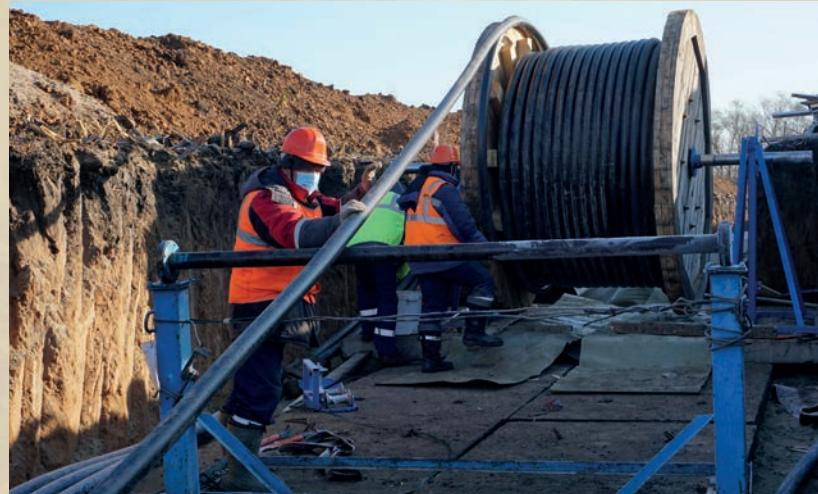
С помощью спецтехники строители параллельно укладывают 6 ниток кабеля в железобетонные лотки..
